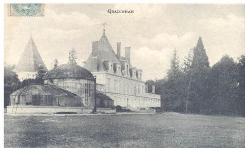
FAÇADE EST DU CHÂTEAU DE LAURENZANE, 1906
