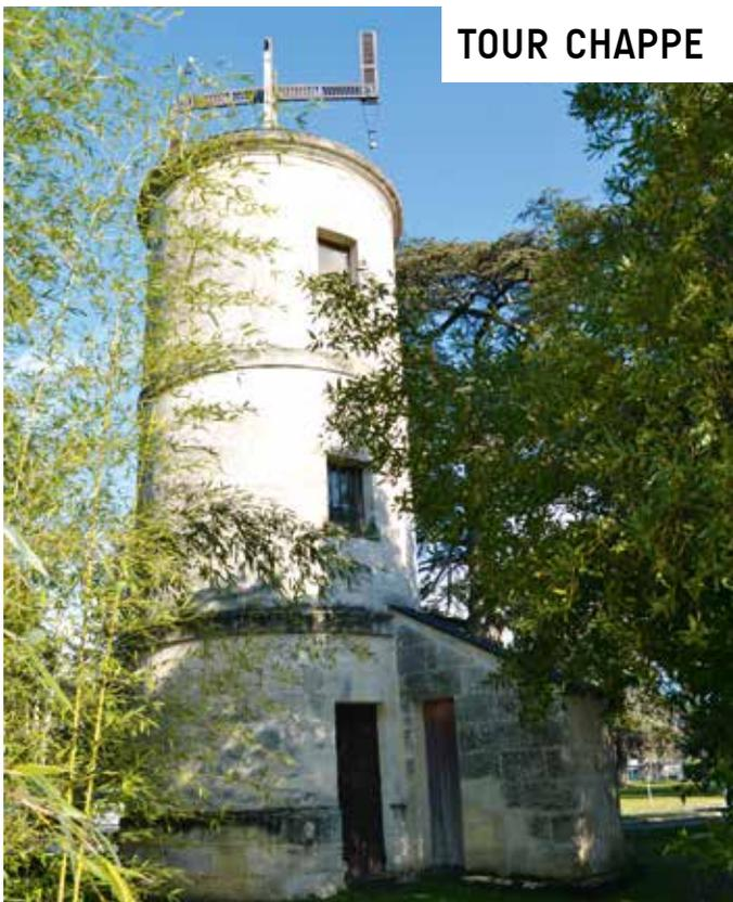
Un des 110 postes relais construits en 1823 entre Paris et Bayonne et servant de télégraphe optique. Un ancêtre de nos antennes relais ? Hauteur 10,70 m.
