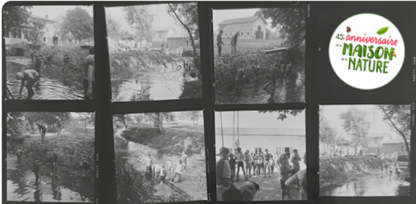
Une série de photos du chantier jeunes, datant de 1978
