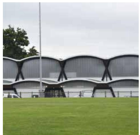
Cet automne, les clubs retrouveront le chemin de la salle des sports Saint-Géry. Réfection de la charpente, le bardage extérieur et la toiture, la peinture, la rénovation des vestiaires, douches, sols et la mise en accessibilité pour les personnes à mobilité réduite.
