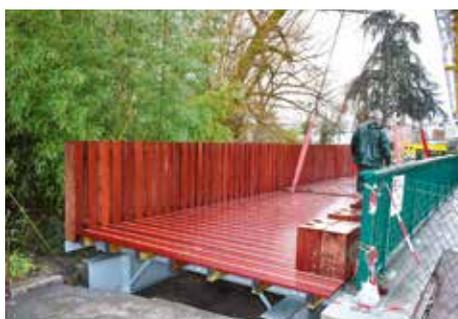
Cette nouvelle passerelle est installée d'un seul tenant au dessus de l'Eau Bourde, cours du Maréchal Juin. Elle a nécessité la venue d'un convoi exceptionnel depuis Nantes et l'intervention d'une grue. Cette structure à l'ossature métallique et au sol en bois exotique, mesure, en effet, 22 mètres de long (dont 17 au-dessus
